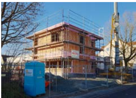
Der Anbau des Kindergartens nimmt langsam Formen an.
