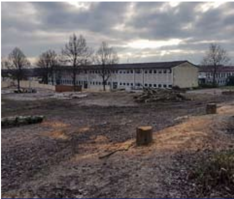
Die Arbeiten für den Neubau der Grundschule haben begonnen.
